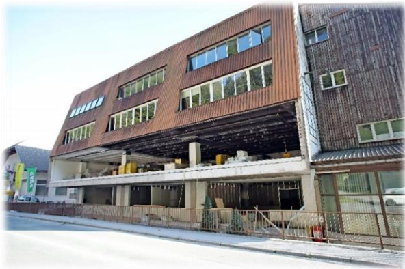
Slika 9: Fotografija lokacije PE Železniki pred prenovo
