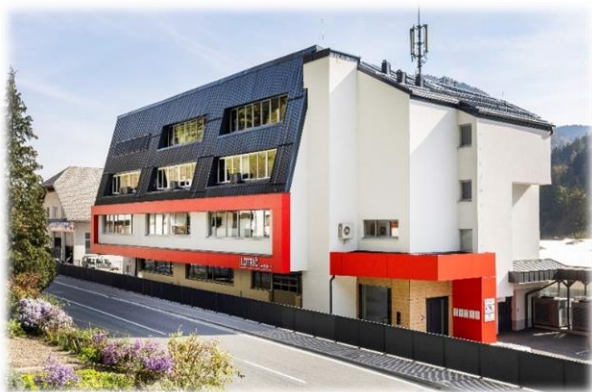
Slika 10: Fotografija lokacije PE železniki po prenovi
